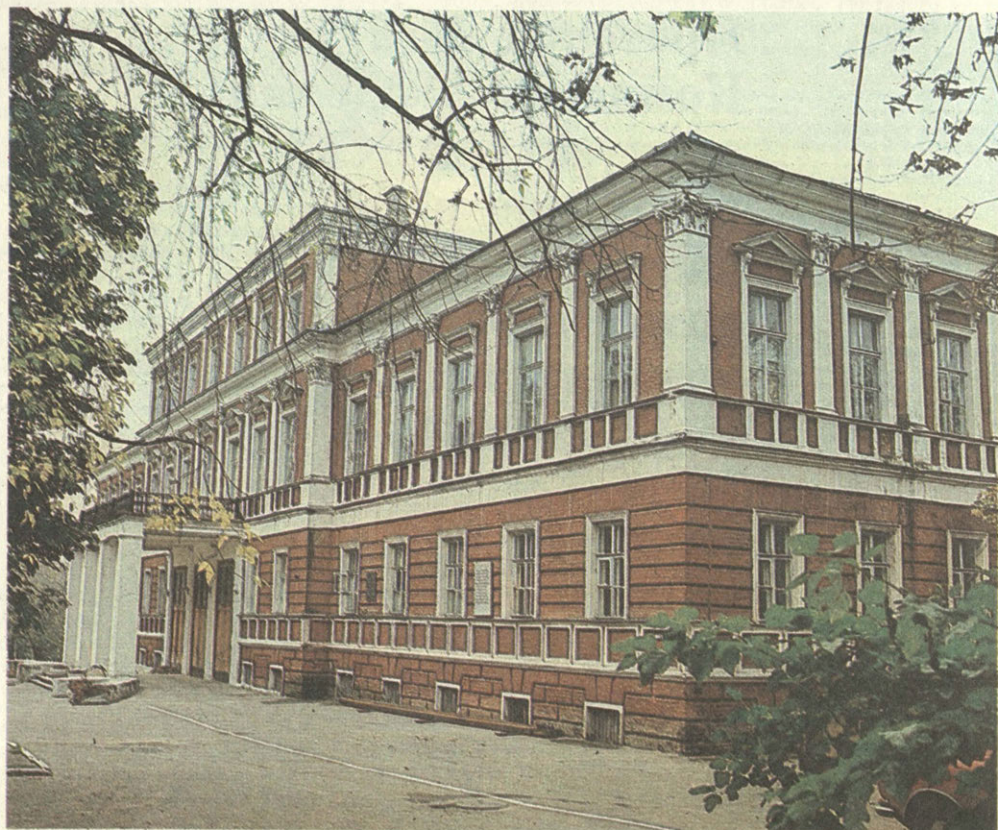
Калуга. Здание Дворянского соборания после восстановления
