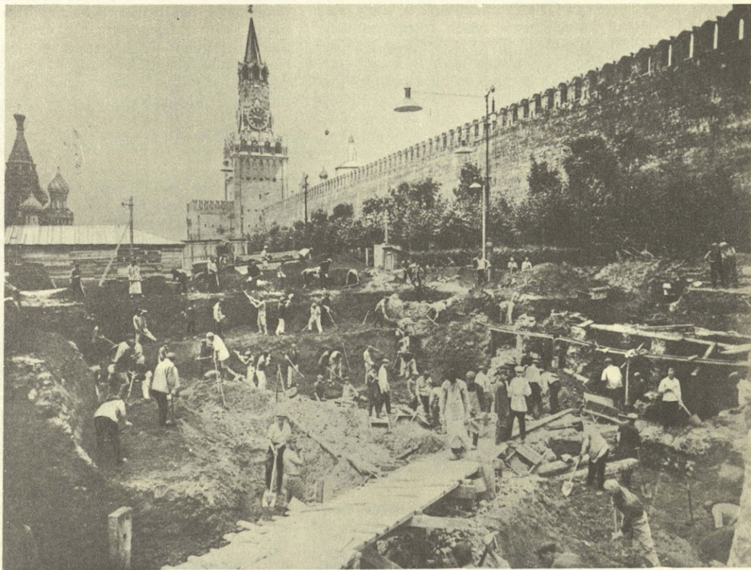
Земляные работы на котловане под гранитный Мавзолей
