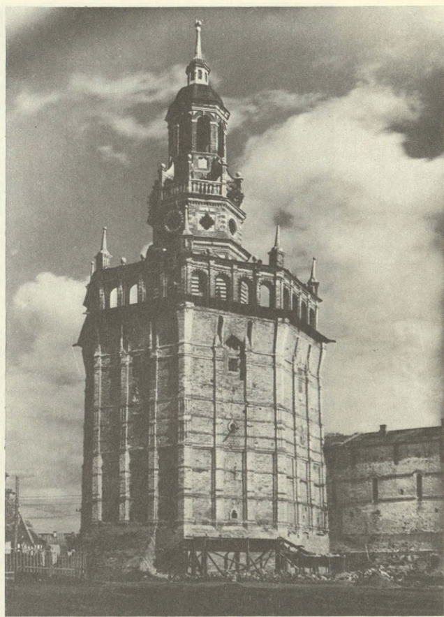
Угличья башня в процессе реставрации основания и цоколя памятника
