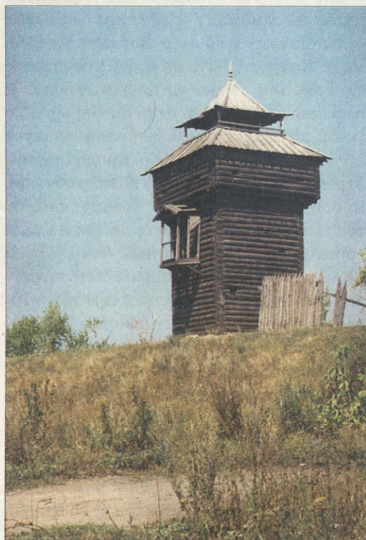
Так выглядели сторожевые башни засечной черты Реконструкция 1960-х годов на участке Пензенской черты
