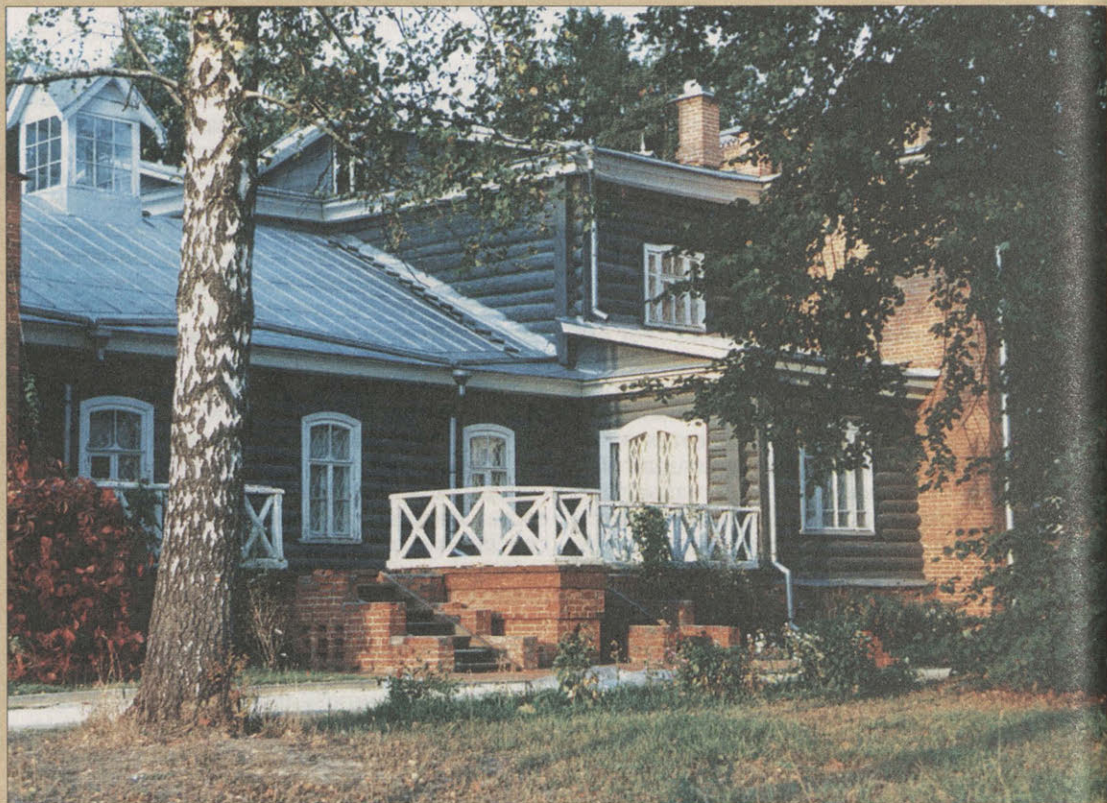
Главный дом. Южный фасад
