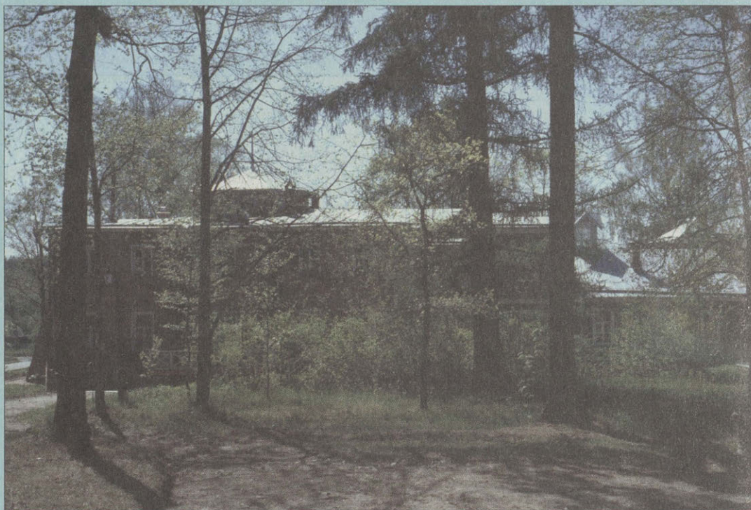
Северный фасад главного дома
