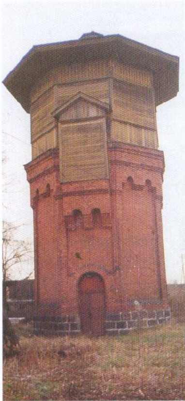
Водокачка на станции Родионово. 1871 г.
