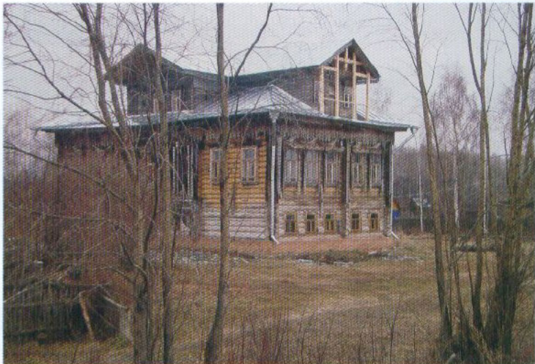
Здание лепной школы. Идет реставрация и оборудование под музей. Фото 2006 г.
