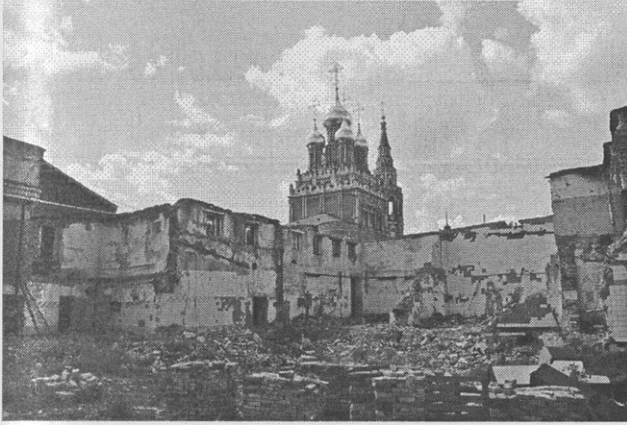
Москва. Разрушение Кадашевской слободы. 2009 г.
